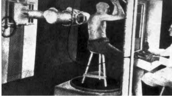
Şekil 14. Döner sandalye metodu ile hastanın 200 Kv'luk Röntgen cihazında tedaviye alınışı. Tüp sabit, hasta X ışını huzmesi etrafında ve tabure üzerinde tedavi süresince 360 derece dönmektedir. Teknisyen kurşunlu paravan arkasında tedaviyi uygulamakta ve kurşun camlı pencereden hastayı izlemektedir. Tüm dünyada hareketli ışın alanı tedavisi metodunun ilk kez Enstitümüzde ilk uygulandığı (İstanbul, 1936).
